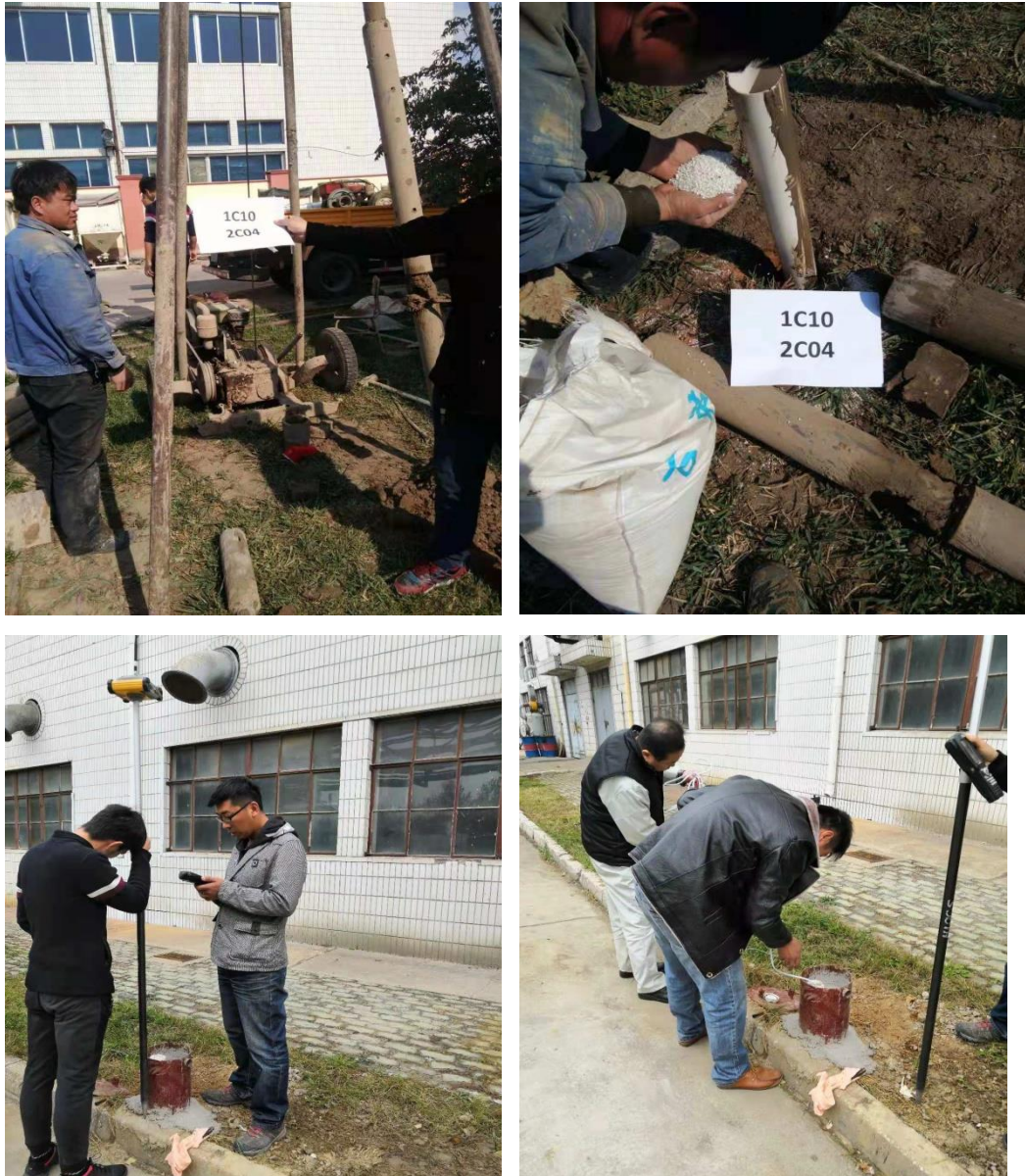
图 3.2-1 现场施工照片
