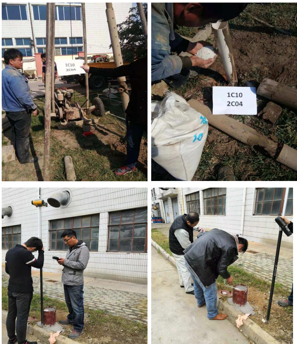
图 3.2-1 现场施工照片
