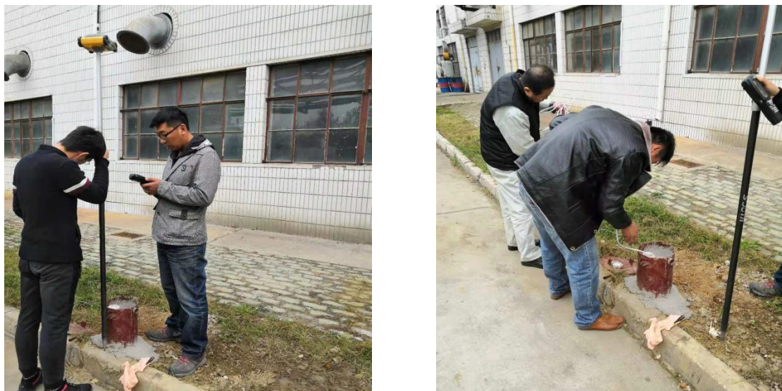
图 2-3-1 现场施工照片
