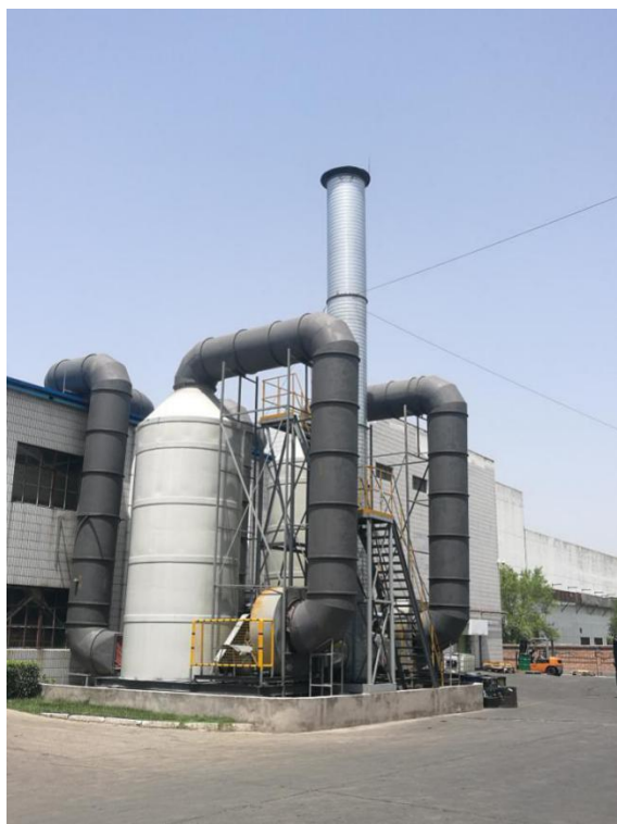
图 2.1-3 胶印二厂工业油烟排气筒 DA007
