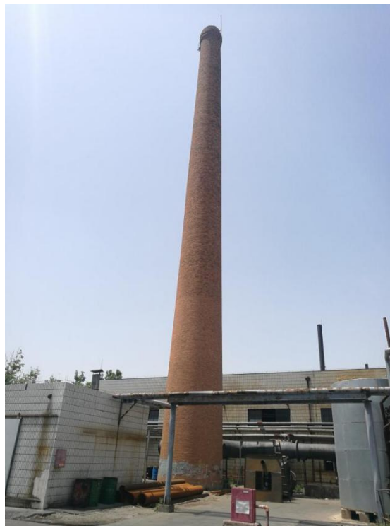
图 2.1-8 燃气锅炉房排气筒 DA021
