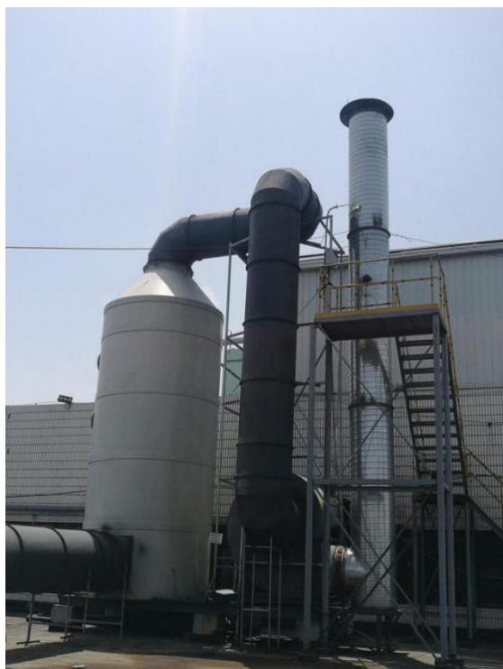
图 2.1-5 胶印一厂工业油烟排气筒 DA009
