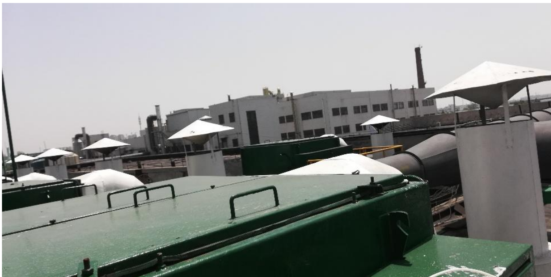
图 2.1-2 胶印二厂配料室排气筒 1-6#
