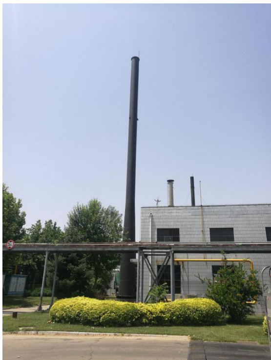
图 2.1-9 热载体炉排气筒 DA022#
